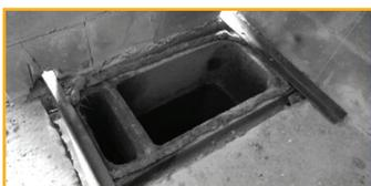
**1.** Уложить минеральный шнур д. 20-40 мм на торцы последнего блока нижележащего этажа.
